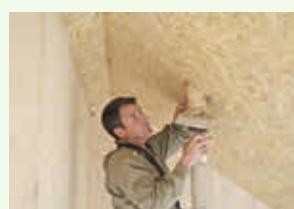
La machine et les ballots d'isolant restent à l'extérieur. La machine est contrôlée à l'aide d'une télécommande, toutes les cavités sont isolées, sans tassement, sans ponts thermiques, et sans avoir à porter les ballots dans le bâtiment.
