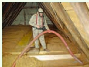
Que ce soit en toiture, en plancher ou en mur, **STEICOzell** peut isoler toutes les constructions, quelle que soit l'épaisseur requise.
