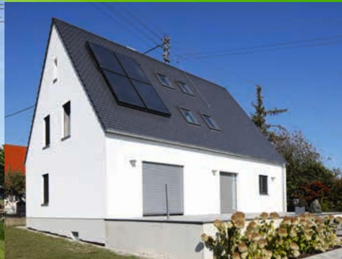
On garde la structure, on augmente la valeur – avec l'isolation de façade STEICO
