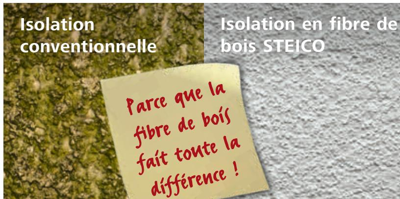
Grâce à leur capacité thermique massive élevée, les panneaux support d'enduit STEICO *protect dry* protègent efficacement contre les mousses et les algues en façade.
