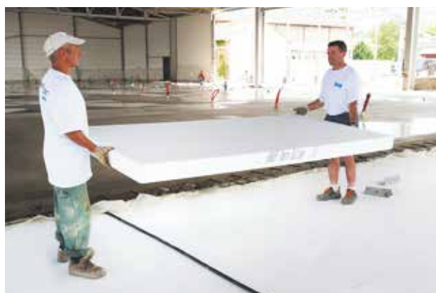
Hypermarché Super U - Pont-du-Château - Entreprise Planche 4 000 m² de Knauf Therm Dallage ép. 115 mm.
