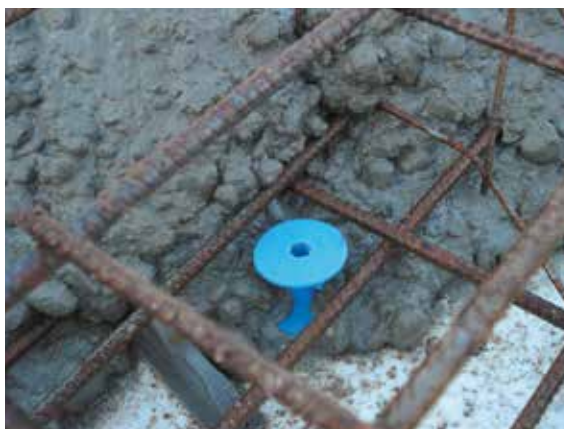
Mise en œuvre de la vis Knauf Spiradal.
