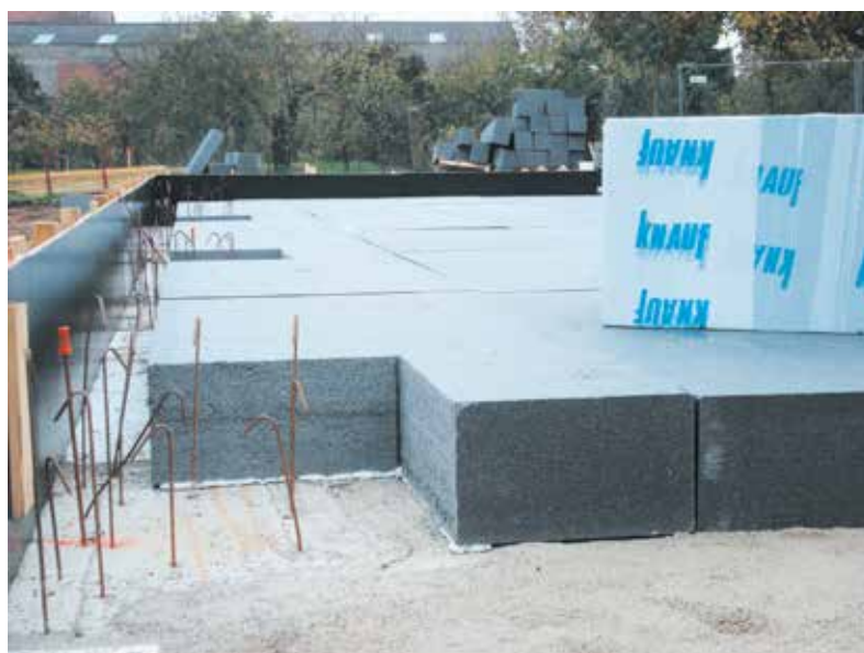
Mise en œuvre des panneaux Knauf XTherm Dalle Portée Rc 30 / épaisseur 315 mm.
