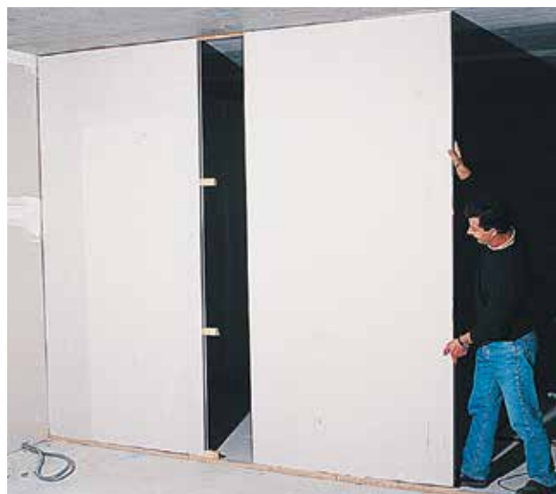
Fig. 2 : Jonction entre deux cloisons
