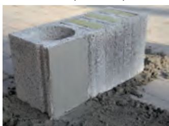
Encollage de la face latérale du bloc poteau
