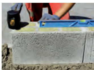
Ajustement du niveau
