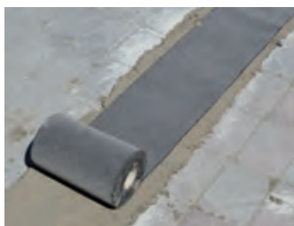
Pose d'une coupure de capillarité entre 2 couches de mortier
