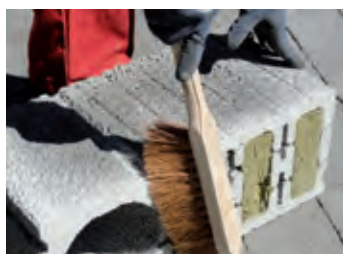
Si nécessaire, dépoussiérer les blocs
