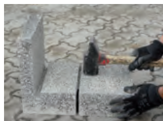
Séparation du bloc inférieur et du bloc supérieur
