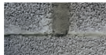
De 3 mm à 5 cm Rebouchage au mortier isolant type Batiponce ou 159 Lankotherm
