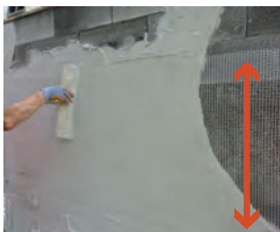
Entoilage aux intersections de plancher, conforme au DTU 20.1
