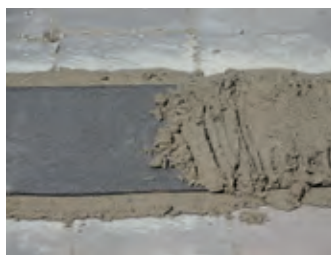
Pose d'une coupure de capillarité entre 2 couches de mortier
