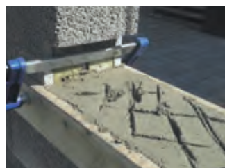
Lit de mortier coffré pour la pose de l'appui
