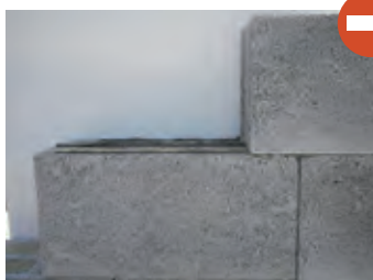
Appui inférieur à 1/3 de la longueur
