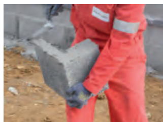
Encollage vertical des éléments
