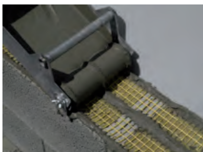
2. Application d'une 2 de couche de colle au-dessus de l'armature
