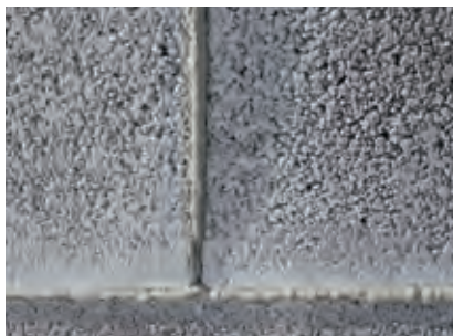
Épaisseur de la colle : entre 1 et 3 mm
