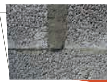
De 3 mm à 5 m mortier isolant (type Batiponce ou 159 Lankotherm)
