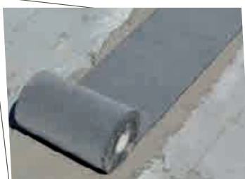
Pose d'une coupure de capillarité entre 2 couches de mortier
