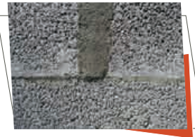
De 3 mm à 5 cm mortier isolant (type Batiponce ou 159 Lankotherm)
