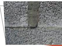
De 3 mm à 5 cm mortier isolant (type Batiponce ou 159 Lankotherm)
