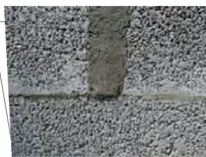
De 3 mm à 5 cm mortier isolant (type Batiponce ou 159 Lankotherm)
