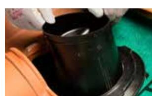
8 - Insérer la sortie de ventilation dans le kit de traversée d'écran universel.
