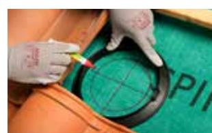
3 - Tracer le diamètre intérieur de la base du kit de traversée d'écran en le centrant sur la marque de la sortie de ventilation.
