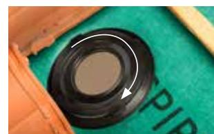
7 - Une fois le kit de traversée d'écran universel vissé, rabattre la lèvre d'étanchéité et découper le joint caoutchouc au diamètre nécessaire.
