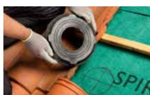
1 - Repérer sur l'écran de sous-toiture l'emplacement de la sortie de ventilation.
