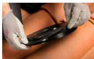
5 - Après avoir remis en place le joint multi-diamètre, relever la lèvre d'étanchéité du kit de traversée d'écran universel.
