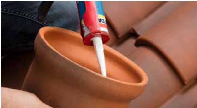
15 - Unjoint mastic continu doit être effectué sur le pourtour total de la lanterne en raccordement avec la tuile à douille afin d'assurer une étanchéité à l'air complète de ce raccordement. Ce joint mastic permet également la fixation de la lanterne à la tuile à douille. Le mastic utilisé devra répondre aux exigences de la norme NF P 85-610.
