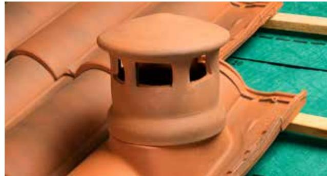
16 - Poser la lanterne en prenant soin de bien la fixer et d'étancher sa jonction avec la tuile à douille.
