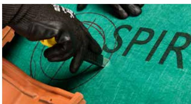
6 - Découper l'écran de sous-toiture au diamètre extérieur.
