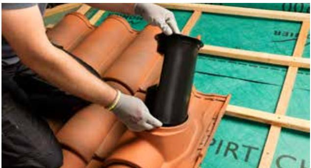
1 - Positionner la tuile à douille, Insérer le manchon de raccordement dans celle-ci.
