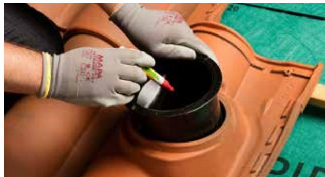
2 - Une fois le manchon à son emplacement, tracer son diamètre intérieur sur l'écran souple de sous-toiture puis retirer le manchon.
