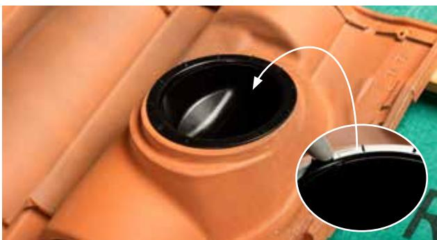
13 - Une fois la tuile douille installée, verrouiller la collerette sur le manchon de raccordement.
