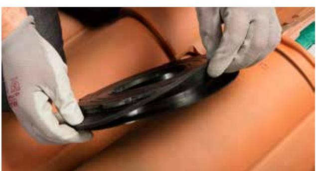
7 - Après avoir remis en place le joint multi-diamètre, relever la lèvre d'étanchéité du kit de traversée d'écran universel.
