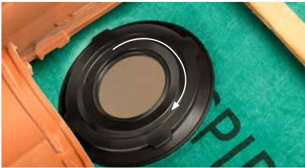
9 - Une fois le kit de traversée d'écran vissé, rabattre la lèvre d'étanchéité et découper le joint caoutchouc au diamètre nécessaire.
