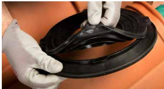
4 - Retirer le joint caoutchouc multi-diamètre du kit de traversée d'écran universel.
