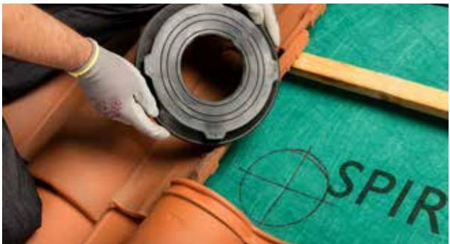
3 - Afin de garantir une étanchéité optimale de l'écran de sous-toiture, l'utilisation du kit de traversée d'écran universel est recommandé. En cas d'absence du kit, il est possible d'utiliser la bande adhésive Flexiroll Alu.
