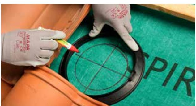
5 - Tracer le diamètre intérieur de la base du kit en le centrant sur la marque du manchon universel.
